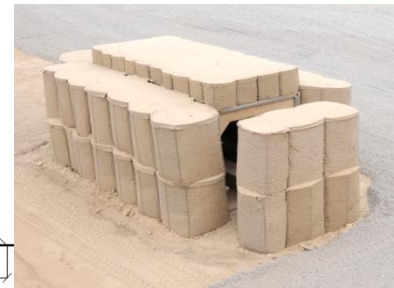
Рис. 4. Обшиване ґрунтом стаціонарне укриття із матрацом від прямого влучання (а), захисне укриття із покриттям з фортифікаційних габіонів «HESCO» (б)
