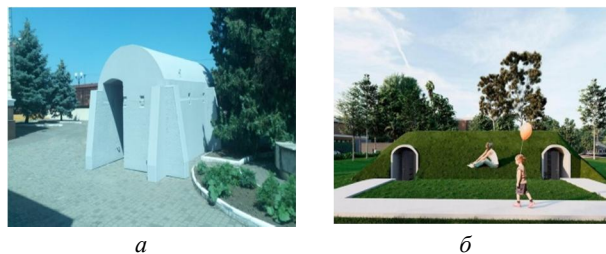
Рис. 5. Захисне укриття «Будинок Хоббіта»: а – типовий вигляд, б – напівзаглиблене укриття
